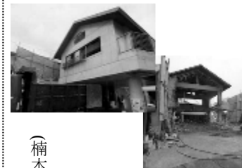
解体工事の様子
