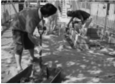
基礎の土台作り
